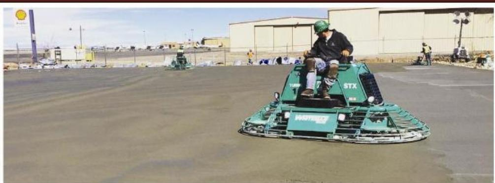
**شرح محصول :** محصولی آماده برای استفاده متشکل از سنگدانه های مصنوعی معدنی و سیمانی می باشد که به صورت خشکه پاشی بر روی سطوح تازه بتنی اجرا می شود.
