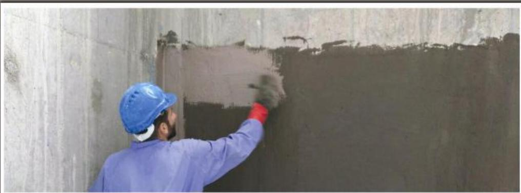
**شرح محصول :** BETOGARD SF-127 پوششی دو جزئی بر پایه ترکیبات شبه سیمانی اصلاح شده و اکرلیک، سوپر الستیک، مناسب برای آب بندی و محافظت سطوح بتنی و پلاسٹر در سطوح داخلی و خارجی تحت فشار می باشد.
