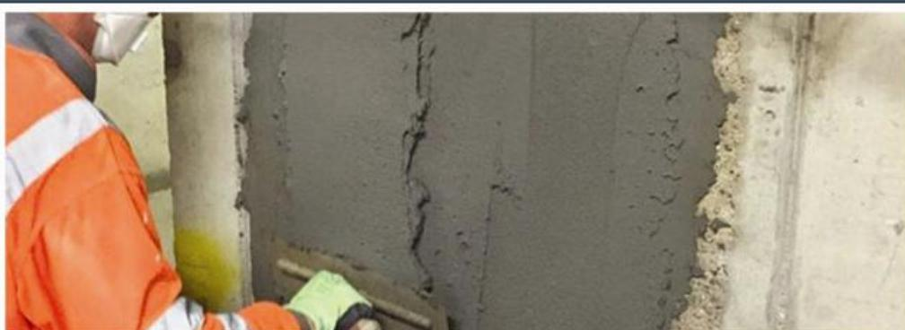
**شرح محصول :** Dezobond P-2200 به عنوان یک افزودنی بر پایه لاتکس طراحی شده است که همراه سیمان پرتلند و ماسه تشکیل ملات پرمقاومتی را برای نصب سرامیک روی دیوار و کف ، سنگ مرمر ، موزائیک ، کاشی معدنی ، آجر لعاب دار و سنگ های طبیعی مهیا می سازد. Dezobond P-2200 همچنین به عنوان لایه پیوند زا در ترمیم سازه های بتنی به کار می رود
