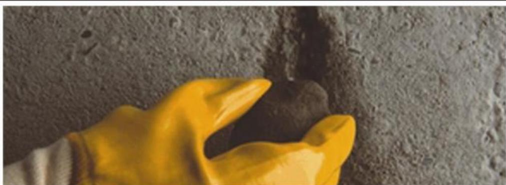
**شرح محصول :** BETOPLUG FIX-10، پودری آماده مصرف و تک جزئی بر پیاه سیمان، انواع افزودنی های زودگیر، زود سخت شونده و ضد آب کننده می باشد که پس از اختلاط با آب، ملاتی با خواص تندگیری بالا و بدون انقباض به منظور جلوگیری از نشت آب جاری در محل ترکها و حفره ها به کار برده می شود.
