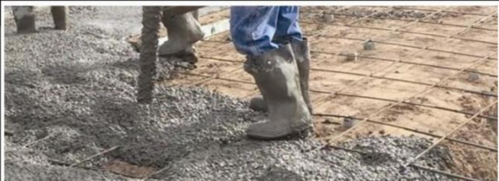
**شرح محصول :** افزودنی آعاده مصرفی است که برای افزایش ویسکوزیته بتن به کار می‌رود. با استفاده از این محصول آب اندادگی کنترل شده و بنابراین مقاومت بتن دربرابر جداشگی افزایش می‌یابد و نهایتاً بتن ریزی را تسهیل می‌کند
