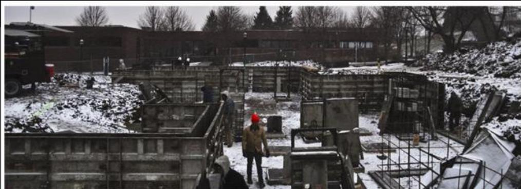
**شرح محصول :** Dezocrete C-440 افزودنی پودری جهت حفاظت بتن در برایر یخ زدگی در دمای پایین تر از صفر درجه میباشد . اگرچه همواره توصیه می شود در هنگام بتن ریزی در هوای سرد تمهدات زیر مورد توجه قرار گرفته شود :
