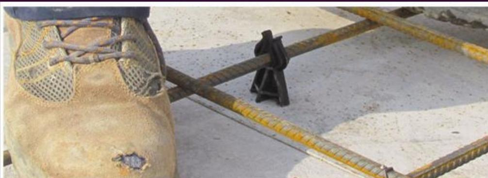
**شرح محصول :** اسپیسر ( SPACER ) در لغت به معنی فاصله گذار می باشد. اسپیسرهای پلاستیکی بتن برای رعایت پوشش میلگردها در سازه های مسلح مثل دالها ، دیوارها ، پی ها و سایر احجام بتنی مسلح قابل استفاده بوده و در پروژه های نظیر سد و تونل و سایر ساختمانها و مستحقات مصرف می شوند.
