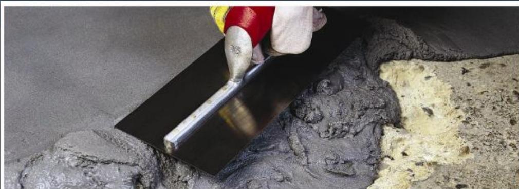
**شرح محصول :** Dezosive A-100 ملات و چسبی خمیری و پایه اپوکسی است که به صورت دو جزئی تهیه شده و برای محدوده وسیعی از عملیات تعمیر و نصب قطعات قابل استفاده می باشد.
