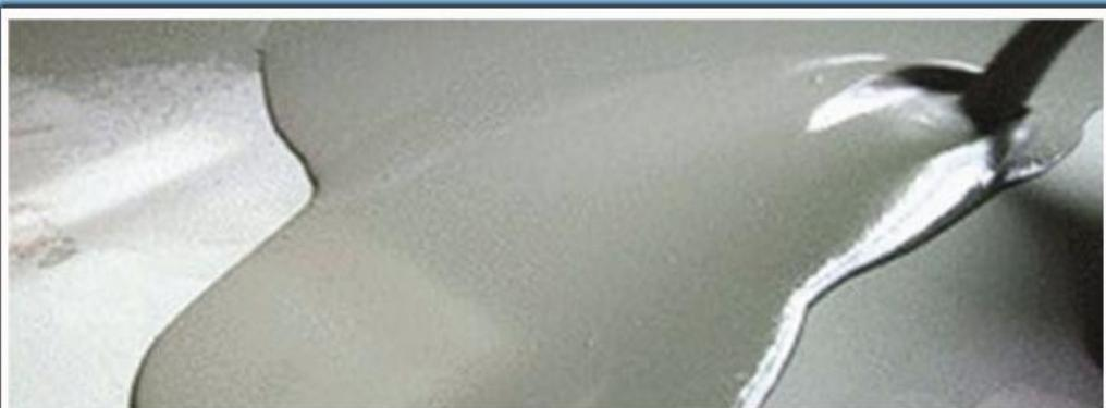
**شرح محصول :** پیک محصول دو جزئی بر پایه سیمان و اکرلیک و تقویت شده با الیاف فلزی و خود تراز می باشد. این محصول مناسب برای ضخامت ۴ تا ۸ میلیمتر بوده و دارای مقاومت سایشی بالا و انعطاف پذیری نسبی برای تحمل ترافیک می باشد.
