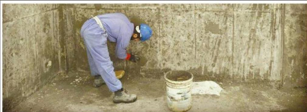
**شرح محصول :** BETOSIVE WP ، یک ملات تک جزئی . پایه سیمانی . اصلاح شده با پلیمر و الیاف . بدون جمع شدگی با مقاومت مکانیکی و فشاری بالا و دارای خواص بالای آب بندی ، جهت ترمیم سازه های بتونی جهت زیرسازی و یا تعمیر می باشد
