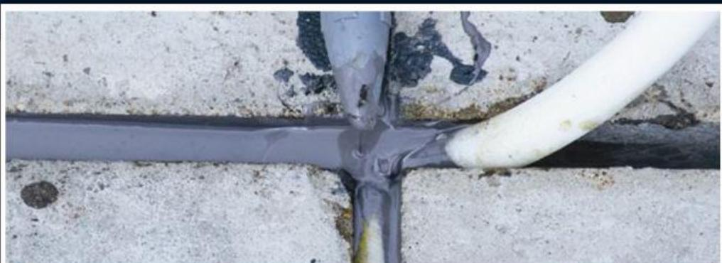
**شرح محصول :** DEZOFLEX PS . یک محصول دوجزئی ، بر پایه پلی سولفاید ، با انعطاف پذیری بالا ، جهت پر کردن و آب بندی درزها می باشد.
